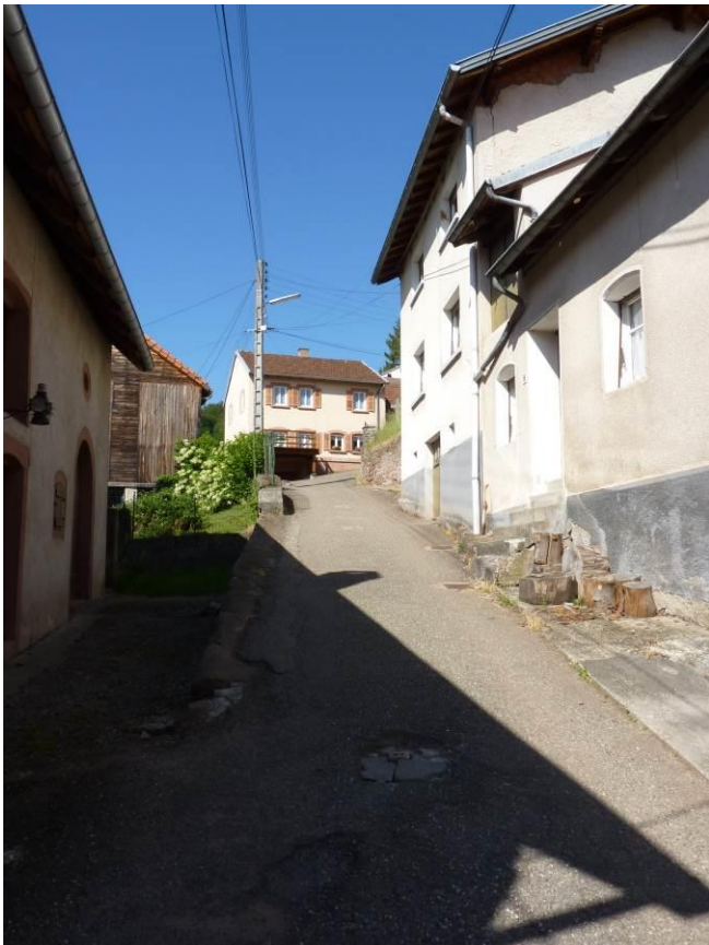
Etroitesse de la rue des Bouleaux, problème de stationnement.
